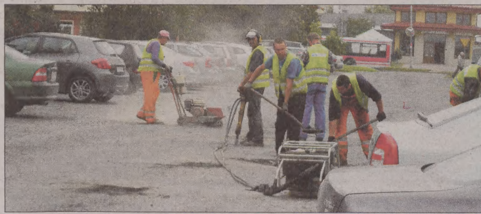
Żałatany parking przy ulicy 11 Listopada. Prace wykonała gdyńska firma.
