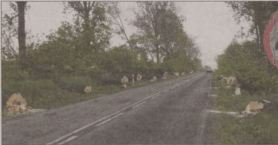
Inwestycję na drodze 214 rozpoczęła w ubiegłym roku wycinka przydrożnych drzew. Kierowcy nową trasą mogą pojechać już za kilkanaście dni.
