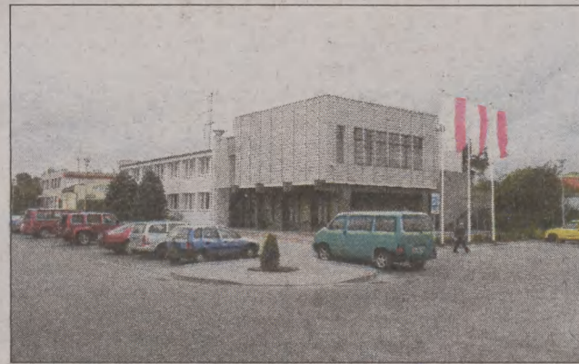
Budynek Urzędu Gminy w Nowej Wsi Lęborskiej w nowym wydaniu. Samorządowcy zakończyli właśnie prace przy jego kompleksowym remoncie.
