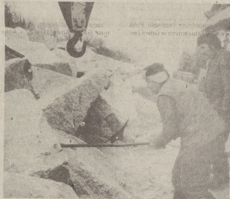
Prace przy usuwaniu starych zniszczeń i umacnianiu nabrzeża w Uście przed zimowymi sztormami wykonuje przedsiębiorstwo „Hydrobudowa” z Gdańska.
