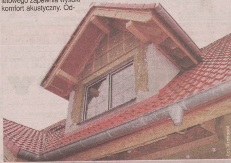
Na zdjęciu: Fragment dachu o konstrukcji drewnianej.
