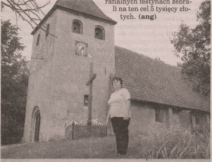
Na zdjęciu: Kościół w Osowie jeszcze przed remontem.
