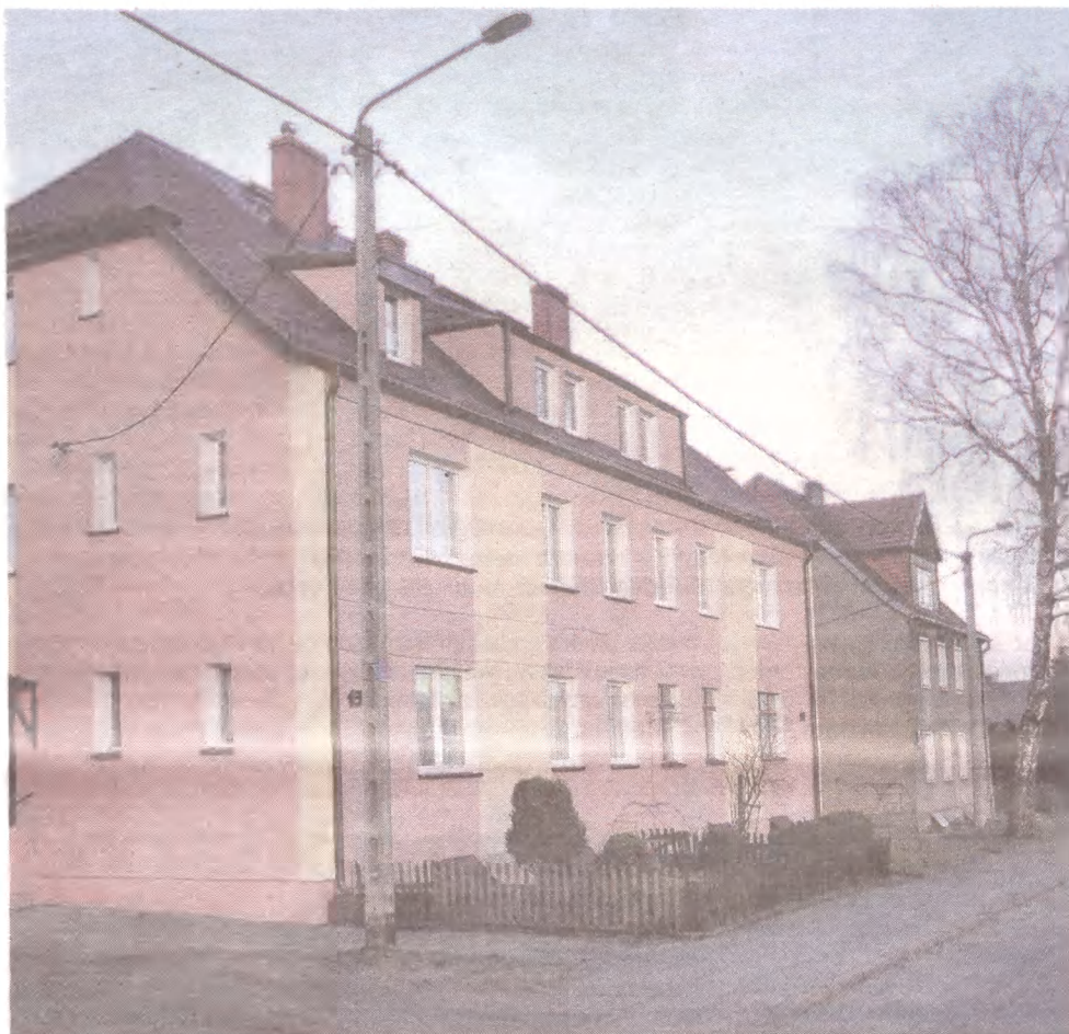
► W 2015 roku przebudowana ma zostać ulica Kolejowa w Miastku - za 700 tys. zł
