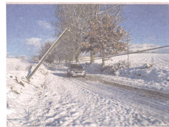
► Wiatr uszkodził słup i linię. Kabel zwisa prawie na drodze. Energetycy obiecali usunąć usterkę
