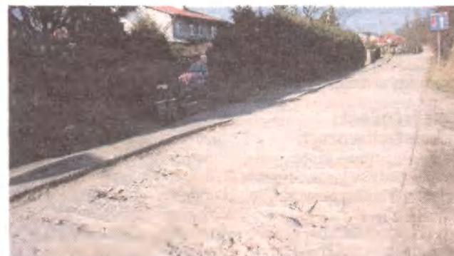
► Ten odcinek ulicy Kolejowej w Miastku będzie przebudowany
