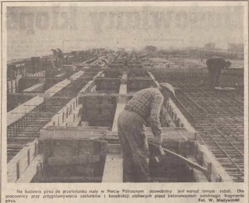
Na budowie pirsu do przeładunku rudy w Porcie Północnym zauważalny jest wzrost tempa robót. O to pracownicy przy przegłowywaniu szalunków i konstrukcji stalowych przed betonowaniem ostatniego fragmentu pirsu. Fot. W. Nieżyński
