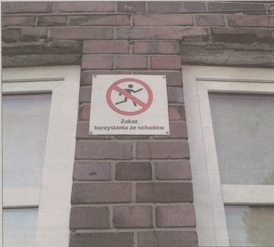
Tabliczka „zakaz korzystania ze schodów” jest wywieszana, gdy stopnie z lastriko są zabezpieczane płynem konserwującym. Już została zdjęta.
