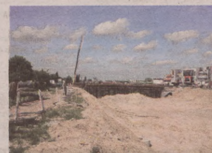
Budowa wiaduktu na wysokości ul. Jasnej
