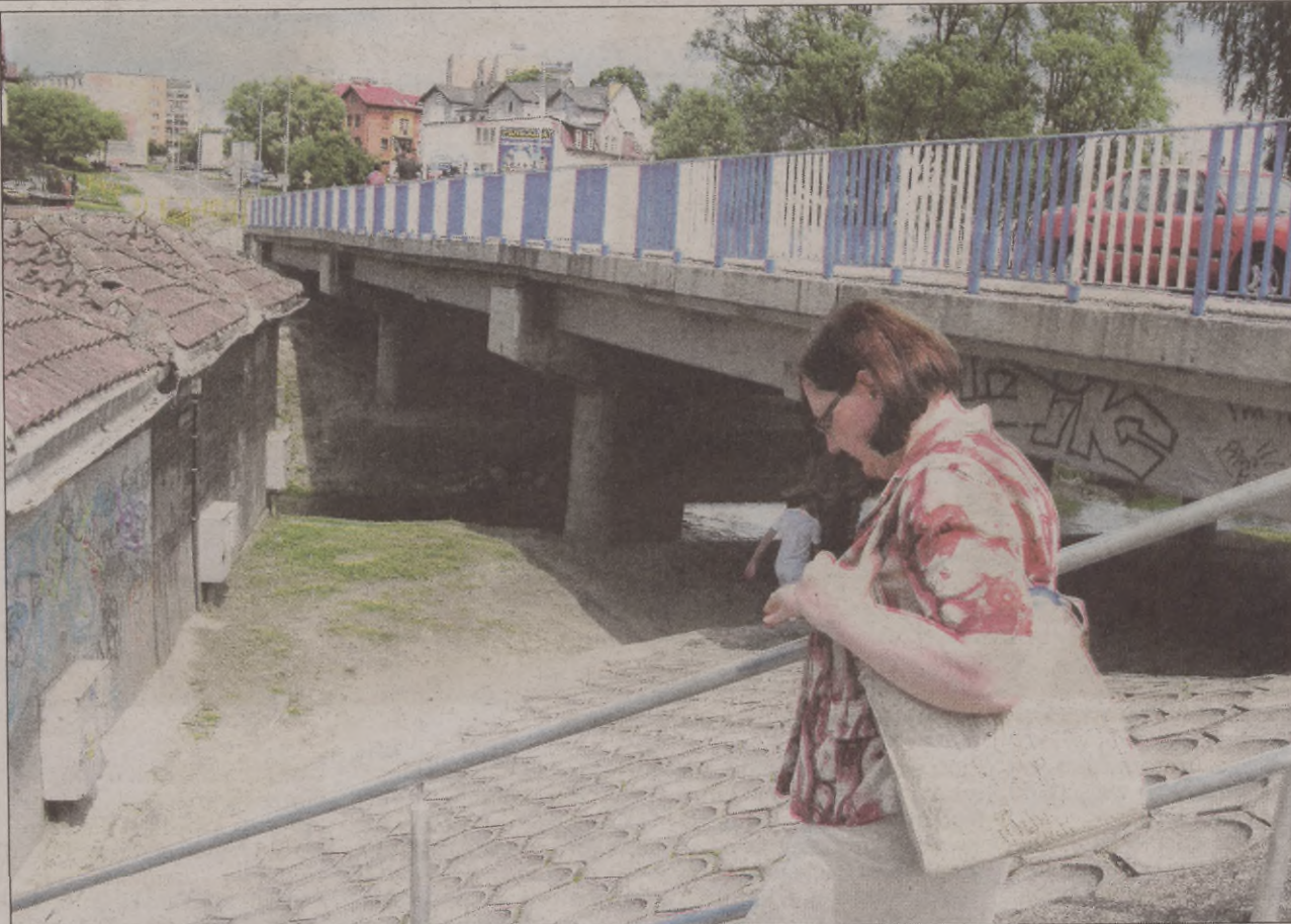
Widoczny na zdjęciu most zostanie zburzony, bo pęka i przecieka.
