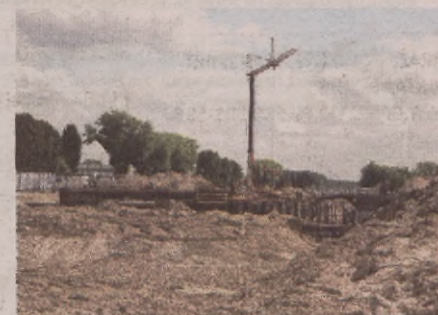
Powstający wiadukt, który połączy ul. Łubinową i Wiosenną
