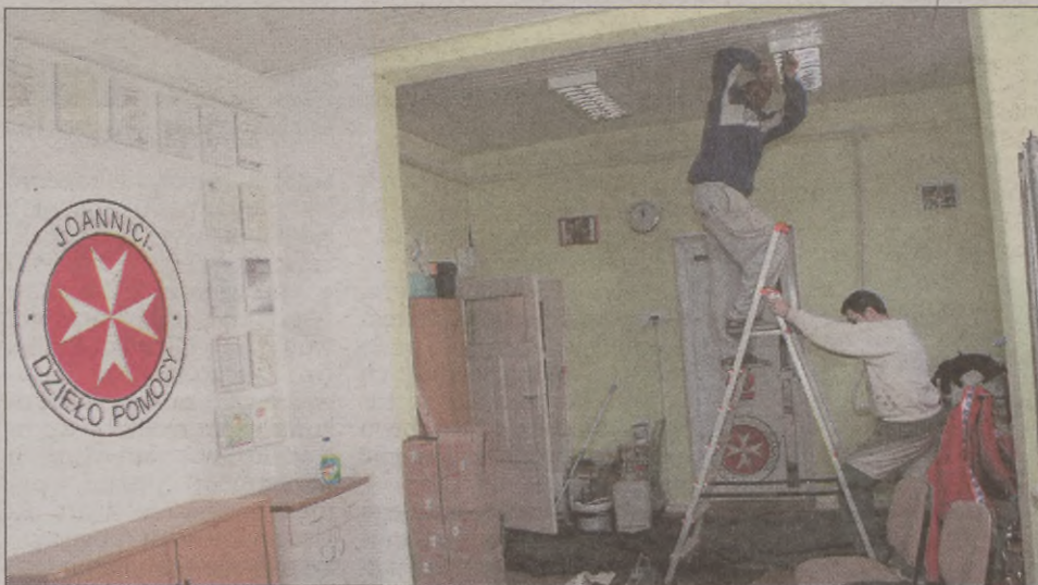
Remont swojej siedziby Joannici przeprowadzają we własnym zakresie.
