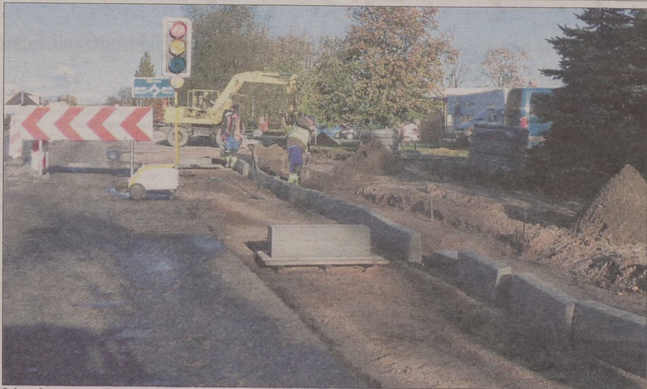
Roboty drogowe przy ulicy Krzywoustego.
