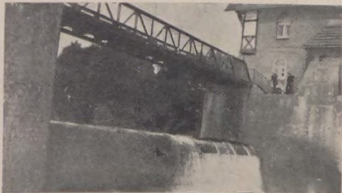
Jaz walcowy w Erdujściu pod Bydgoszczą.
