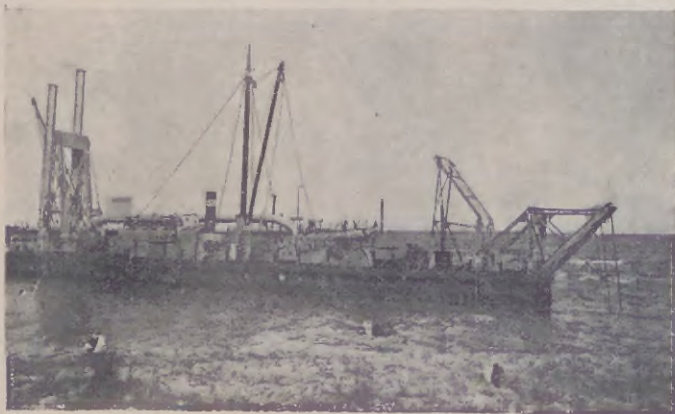
Draga ssąca przy pracy pogłębiania portu gdyńskiego do 10 metrów.
