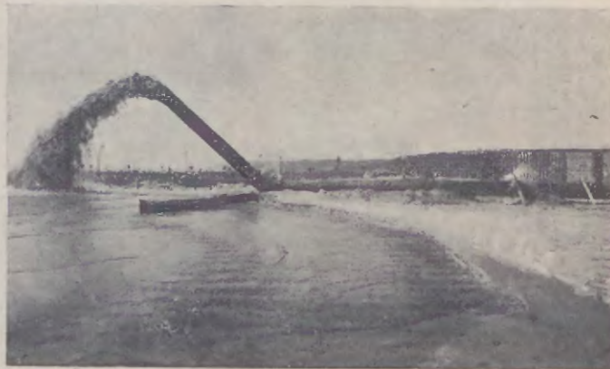
Draga ssąca pogłębia port gdyński i nadwarstwu tereny celem podniesienia ich poziomu.
