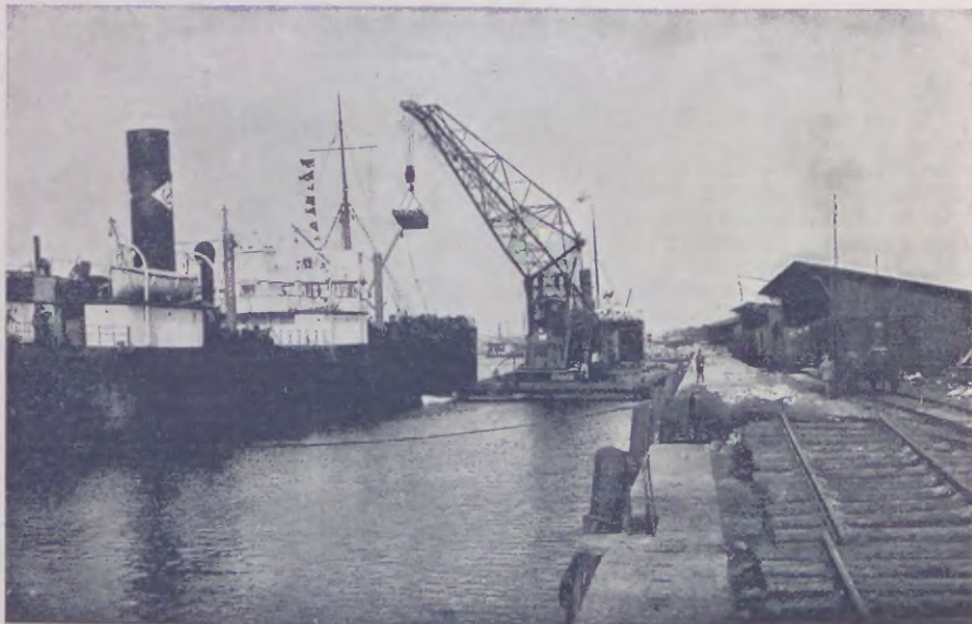
Port gdański: wyladunek rudy przy pomocy pływającego żurawia. The port of Danzig: unloading of ore with a floating crane.
