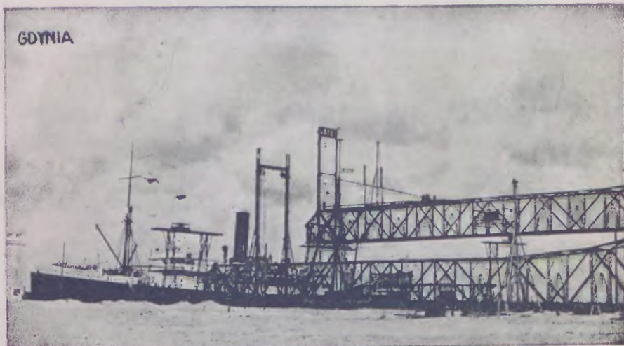
Montaż dwóch dźwigów morskich w Gdyni. Jeden most już podniesiony, drugi na piasku. Installing two new cranes in Gdynia. One is already up, the other can be seen lying on the sand.
