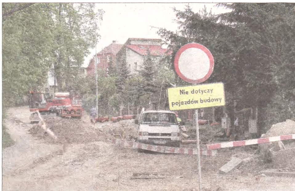
Prace na ulicy Kościuszki w Bytowie. Ulica będzie gotowa w październiku.
