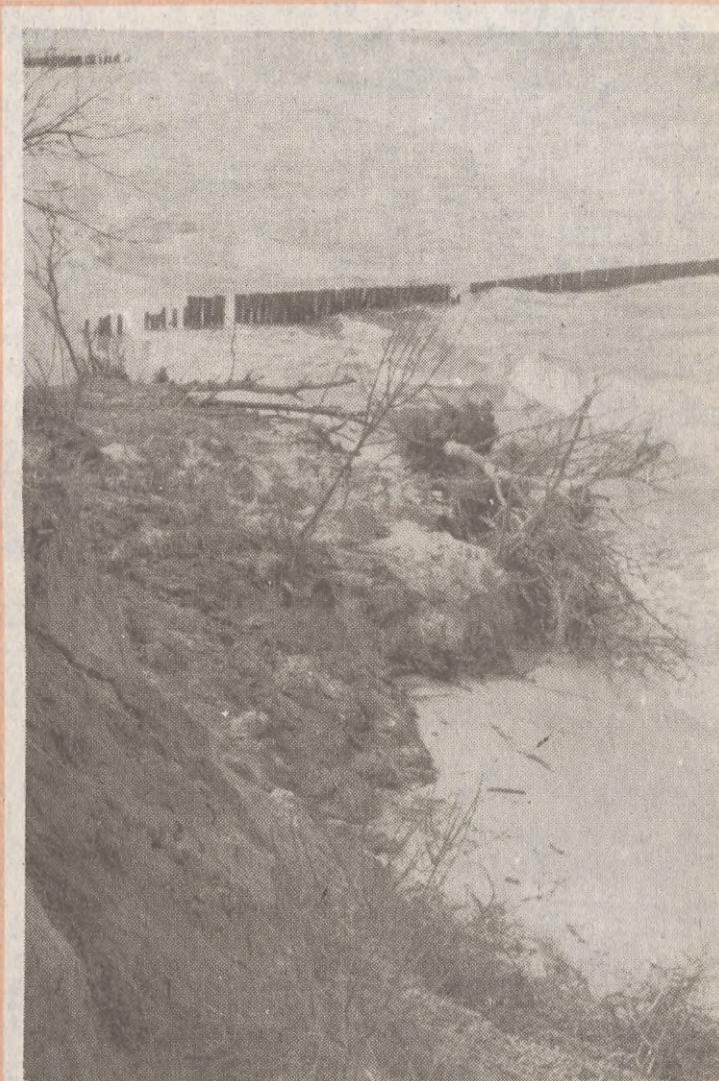
Ostatnie jesienne sztormy poczyniły kolejne zniszczenia brzegu morskiego. Zjawisko silnej erozji brzegu morskiego można obserwować w Jarosławcu. Tu po każdym sztormie kilka drzew lub krzewów wpada do morza. (kar)
