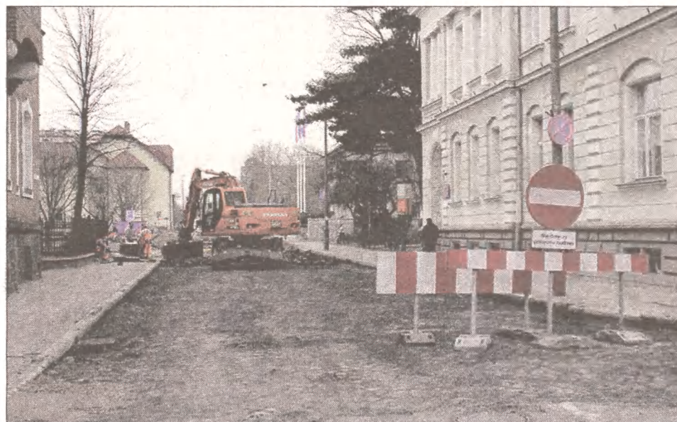
Rozpoczęły się już prace przy układaniu kanalizacji deszczowej. Szykują się utrudnienia w ruchu.
