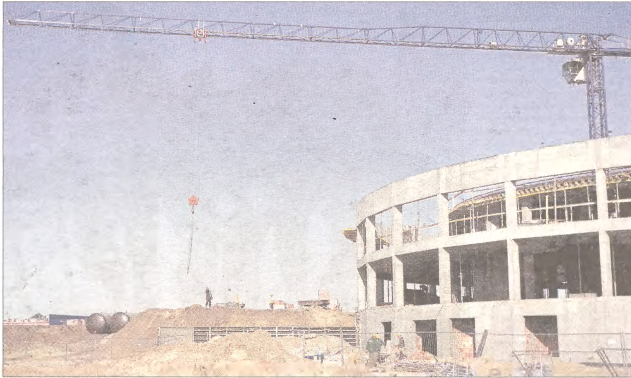
Budowa akwaparku trwa, ale nie są jeszcze wykonane niektóre rzeczy, które powinny być zrobione w ub. roku.
