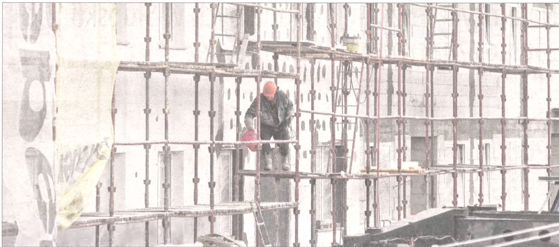
W nowym budynku socjalnym będą 24 mieszkania. Nowi lokatorzy do budynku wprowadzą się prawdopodobnie jeszcze wiosną tego roku.
