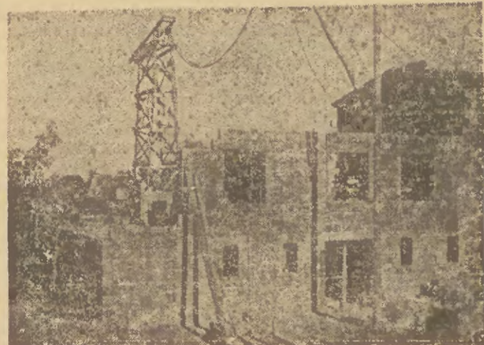
Zdjęcie powyższe nie przedstawia bynajmniej budowy srogoniowej twierdzy z katapultą, umieszczoną poza budynkiem. Szare mury wykonane są z betonu i pustaków trzcinowo-betonowych, z których składają się doświadczalne domki budowane w Orlowie. Szczegółowe ciekawych doświadczeń budowlanych znajdziecie w artykule p. t. „Szkoła pomysłów” (3 str.)
