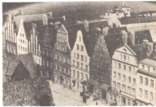
NRD. W nadmorskiej części Rostocku, starego hanzeatyckiego miasta, trwa rekonstrukcja zabytkowych kamienic. Prace skupiają się głównie na zabudowie ulicy Długiej i w Starym Porcie.
