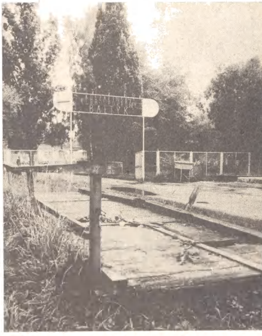
Przez długie lata mostek na Dzierżęcine koło stadionu Baltyku był drewniany. Obecnie zastąpiono go potężną konstrukcją żelazno-betonową. — No i bardzo dobrze... To znaczy — byłoby dobrze, gdyby po pierwsze — do końca roboty i wykonano również te części, które ewidentnie wrak starego, drewnianego mostka, nie dający urody wejściu na stadion. (b)
