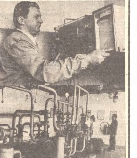
Pracownicy Instytutu Elektrotechniki AGH w Krakowie dr. inż. Andrzej Kaczmarek i mgr inż. Wiesław Syrek opracowali pierwszą w kraju instalację pomiarowo-ostrogę do ciągłej kontroli zagrożenia wybuchowego mieszaniny propanowo-butanowej w powietrzu. Instalacja wykonana została z materiałów krajowych, w oparciu o aparaturę również rodzimej produkcji. Zainstalowana została w rozlewni gazu w Nowym Targu. Co 30 sekund informuje ona o stopniu stężenia gazu sygnałami wzrokowymi i dźwiękowymi. (dcr)
