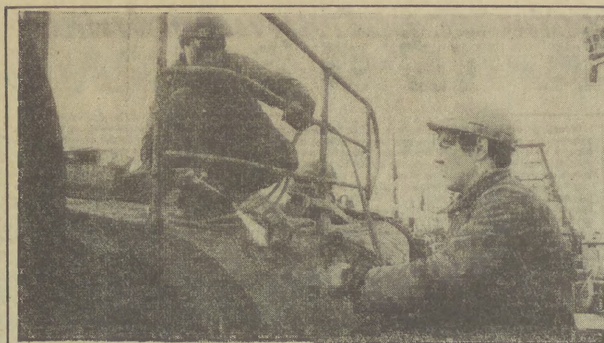
Najmłodszą lecznicą statków na naszym wybrzeżu jest Morska Stocznia Remontowa w Słwinoujściu. Specjalizuje się w naprawach głównie jednostek rybackich armatorów krajowych i zagranicznych. Wyposażona w dwa doki o niewielkim udźwigu nie może rozszerzać swoich usług na większe jednostki. Równocześnie jednak w coraz szerszym zakresie świadczy usługi typu serwisowego dla promów posażersko-samochodowych Polskiej Żeglugi Bałtyckiej. Na zdjęciu: prace remontowe przy jednostkach bandery NRD. (Hś)
