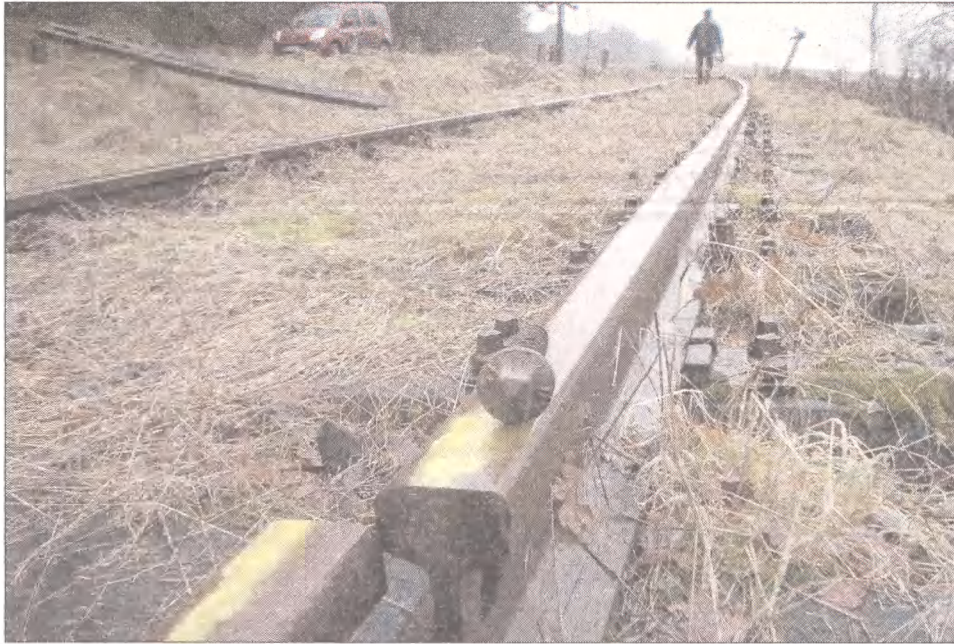
Tory koło Gumieńca. Na zdjęciu widać niedokończoną pracę złodziei złomu.
