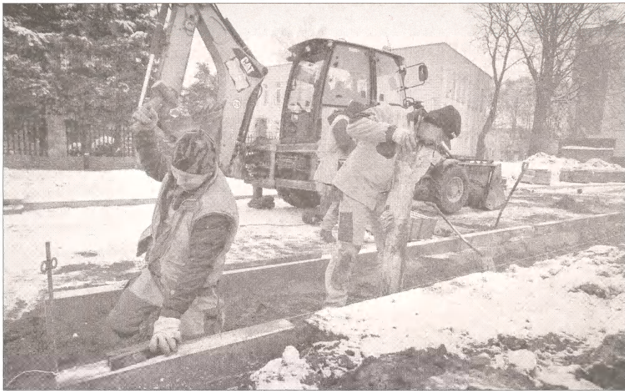
Ekipa budowlana pracuje przy remoncie ulicy 9 Marca.
