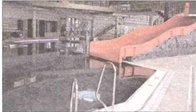
Wykonawca potrzebuje jeszcze niespełna miesiąc, aby zakończyć prace przy budowie basenu w Bytowie.
