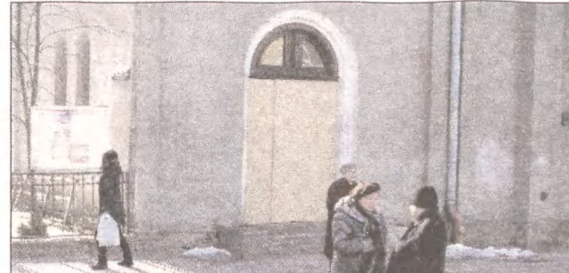
Rozpoczęła się już renowacja kościelnych drzwi. Lada dzień zaczną się kolejne prace na zewnątrz świątyni.
