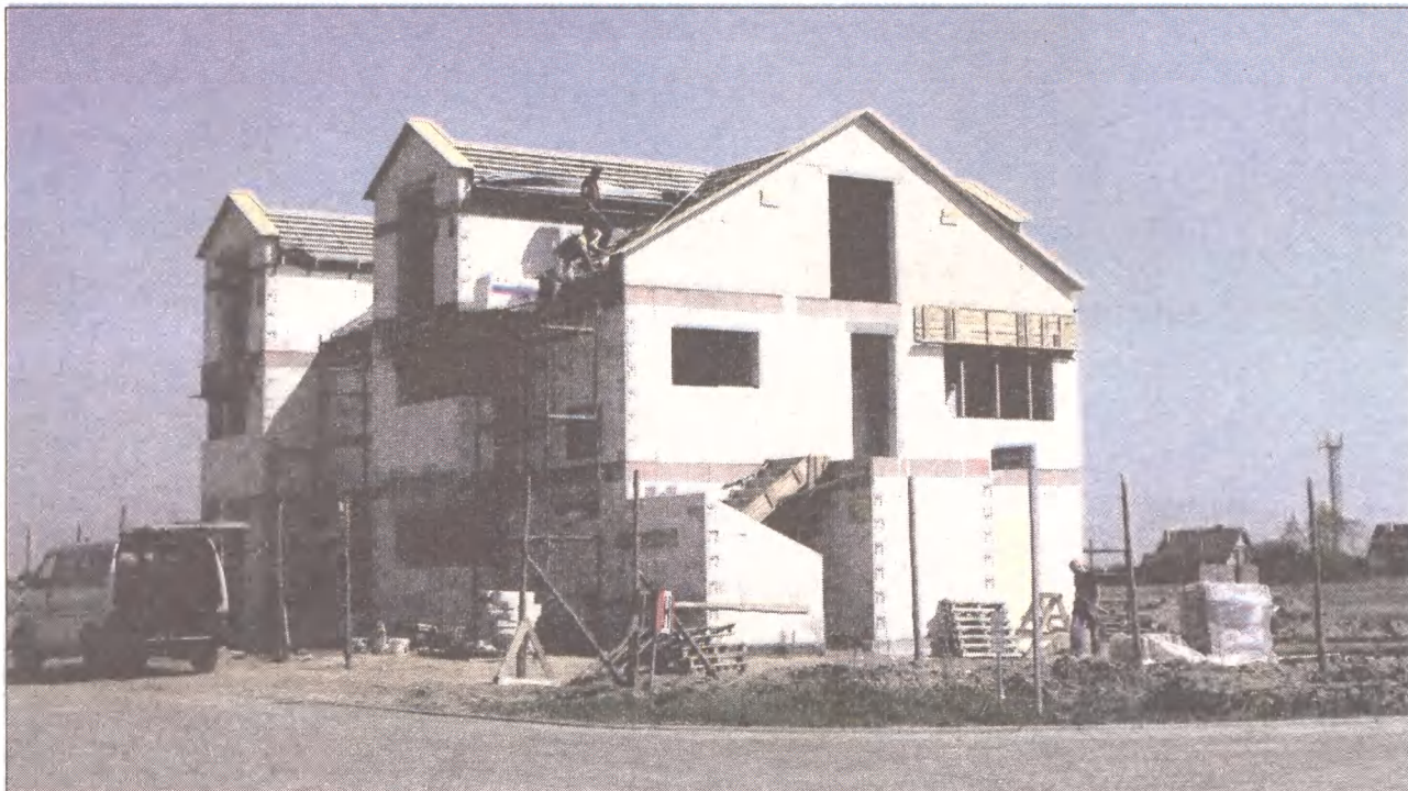
Budynków na osiedle Przy Lesie w Słupsku jest jeszcze niewiele, ale teren jest już uzbrojony i ma sieć dróg.
