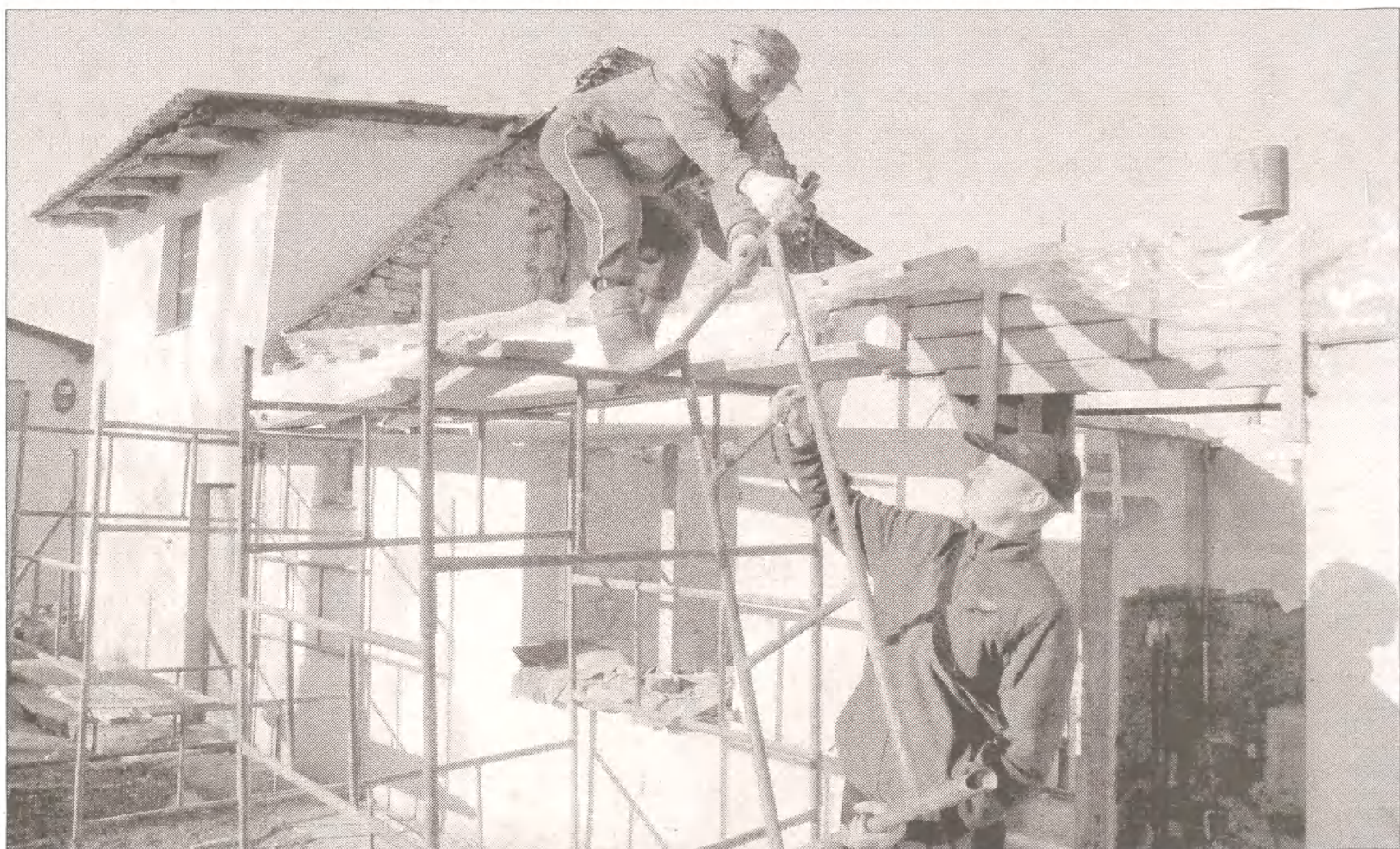
Adam Zboch (na rusztowaniu) i Piotr Pałubicki podczas prac przy wylewaniu betonowego wienca na murach spalonego domu.
