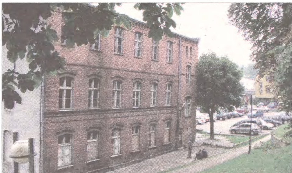
W tym budynku powstanie bytowski inkubator przedsiębiorczości.
