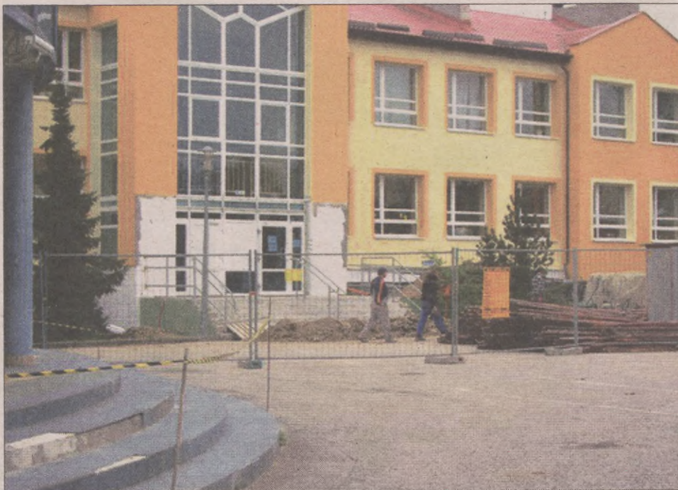
Z powodu termomodernizacji szkoły główne wejście jest zamknięte.
