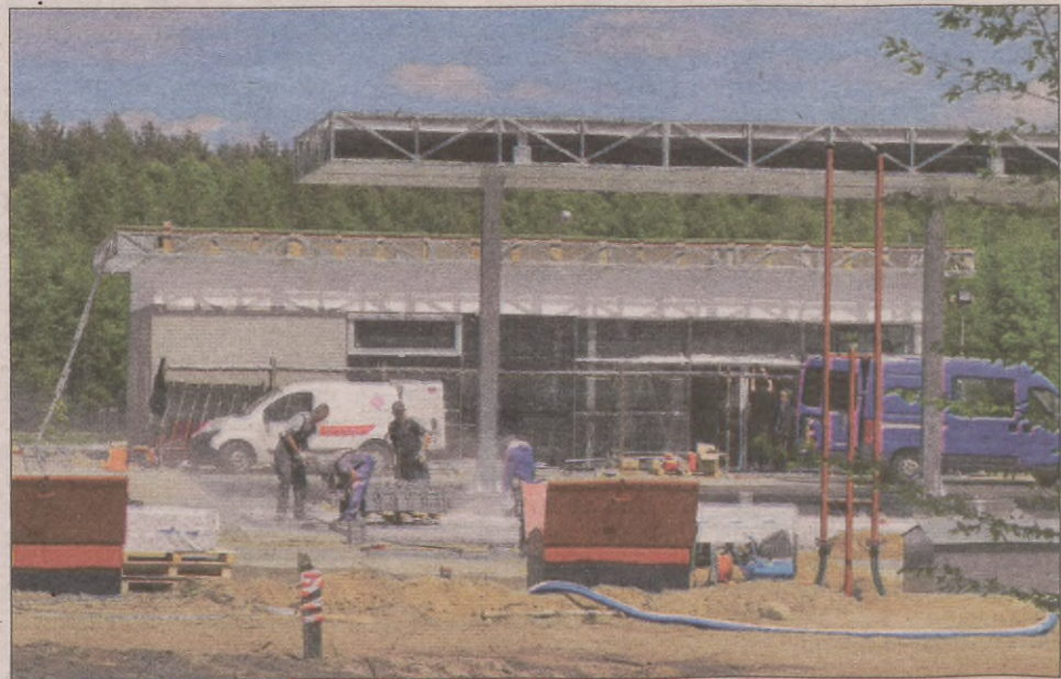
Budowa stacji Oktan pod Ustką.
