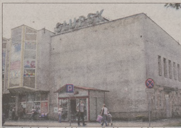
Zegar z budynku dworca kolejowego zniknął, bo po raz kolejny się zepsuł. Przedstawiciele PKP zapowiadają, że po naprawie wróci jeszcze w czerwcu.
