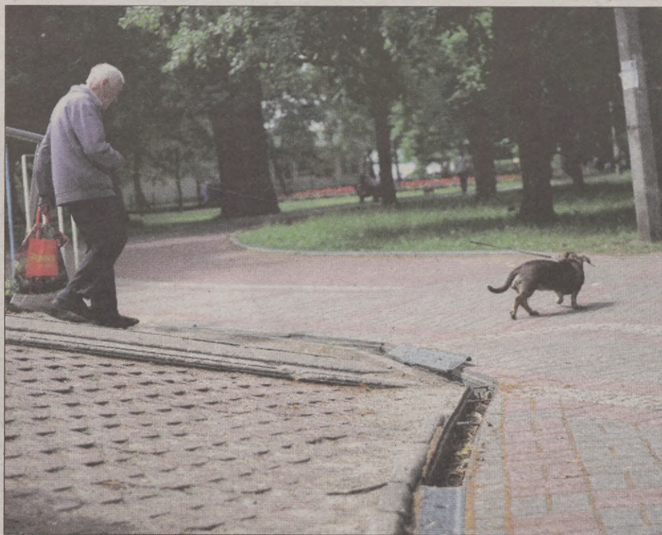
Wejście na mostek i obie kładki zostaną niebawem zmodernizowane.
