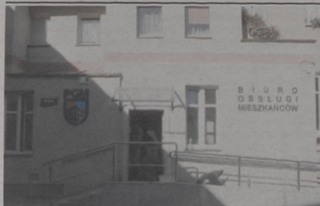
Ostatnie prace przy nowym Biurze Obsługi Klienta przy pl. Zwycięstwa 4 dobiegają końca.
