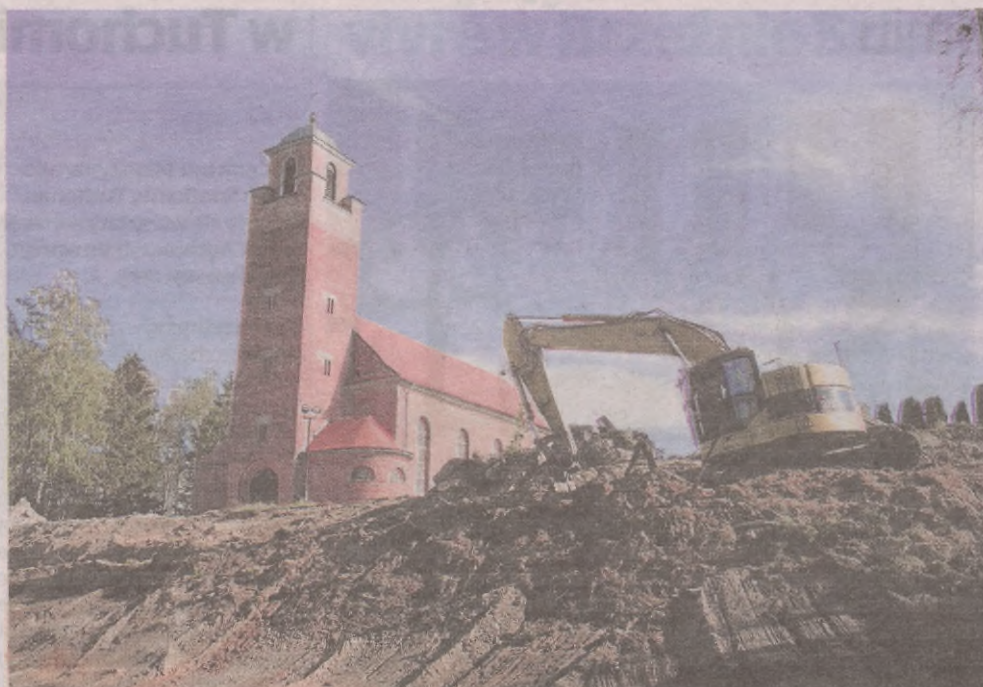
► Rozpoczęły się prace związane z budową nowych schodów prowadzących do kościoła parafialnego w Zapcieniu (gmina Lipnica). Na początek ciężki sprzęt wyrównał skarpe znajdującą się przed kościołem oraz usunięte zostały stare schody. Prace powinny zakończyć się w październiku tego roku. (ANG)
