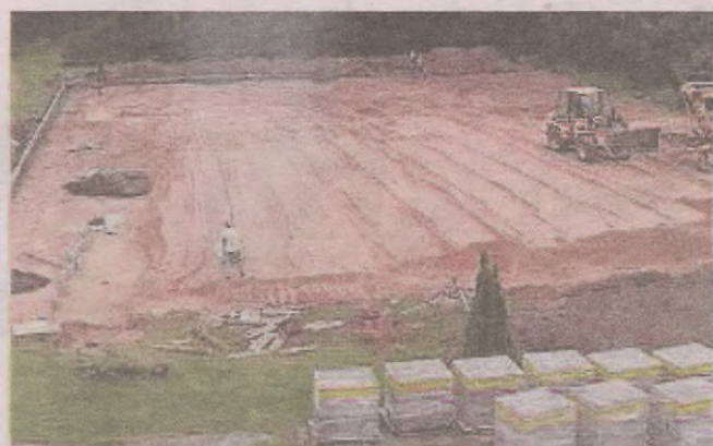
► Trwa budowa boiska wielofunkcyjnego przy Zespole Szkół Ponadgimnazjalnych w Łodzierzy
