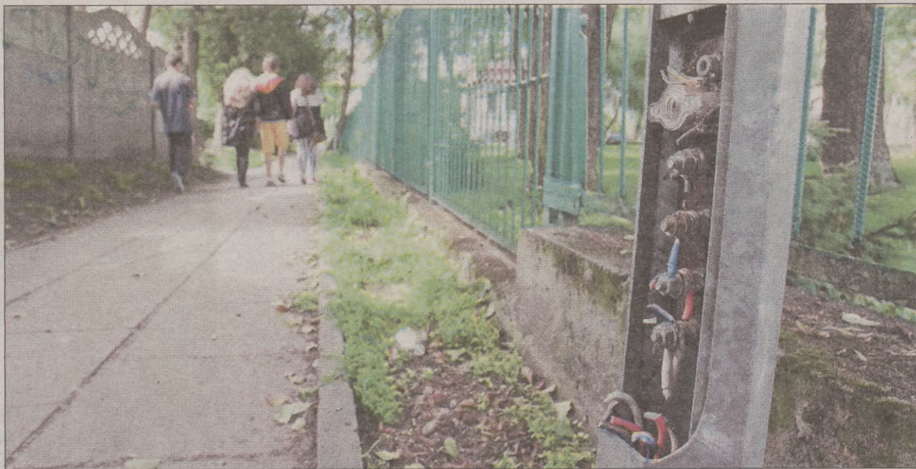
Lampy w alejce są uszkodzone. Energa Oświetlenie naprawi je dopiero tuż przed rozpoczęciem roku szkolnego.
