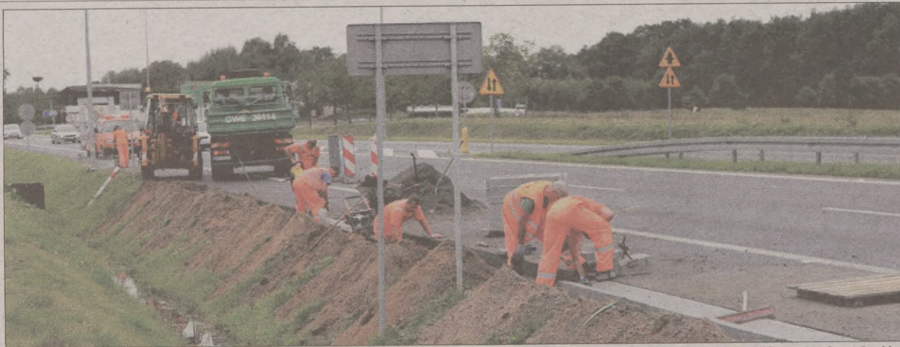
Prace remontowe na słupskiej obwodnicy. GDDKiA informuje, że część prac zostanie wykonanych w ramach gwarancji przez firmę Strabag. Część natomiast w ramach bieżącego utrzymania dróg.
