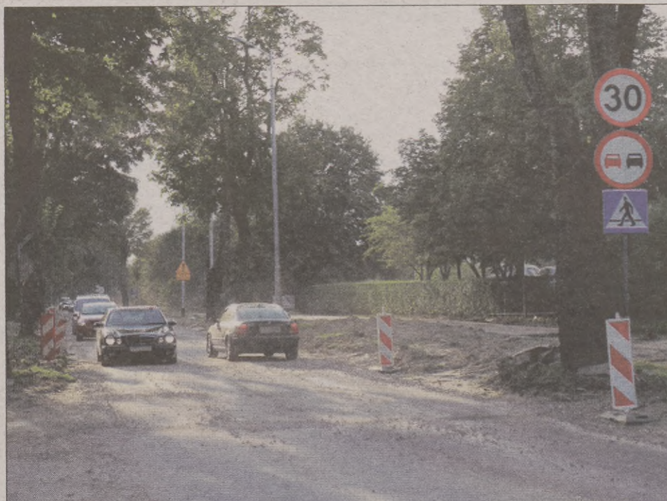
Kierowcy narzekają na utrudnienia podczas remontu nawierzchni al. 3 Maja.
