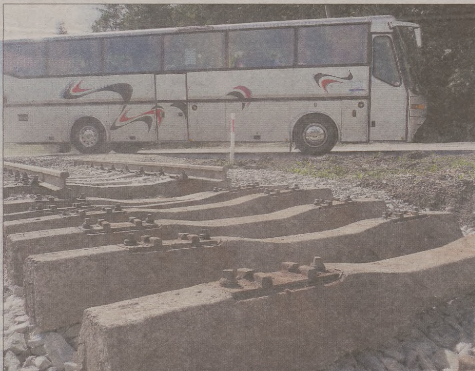
Remont torowiska w Rybkach.
