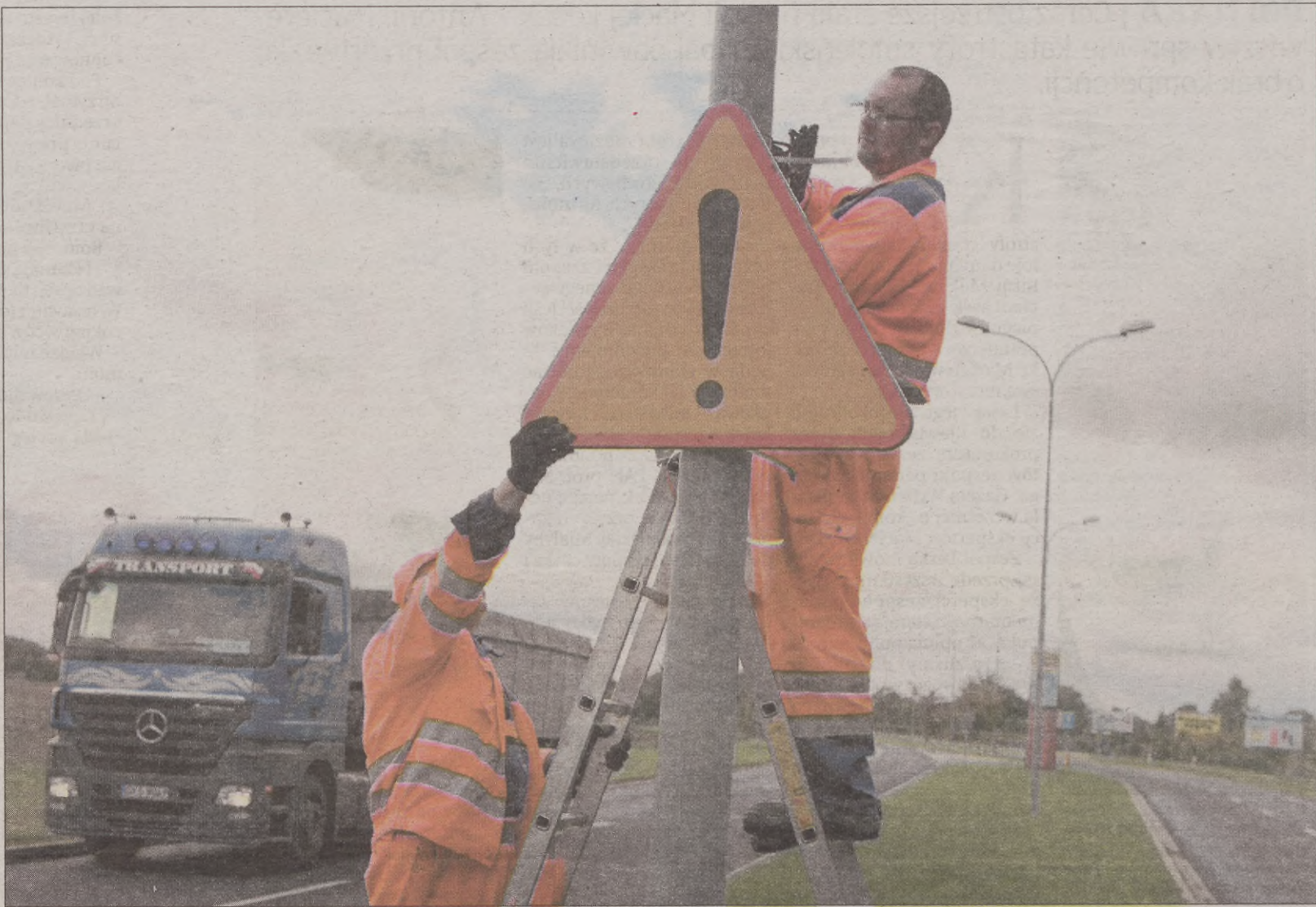
Już wczoraj montowano znaki przy tymczasowej ścieżce rowerowej do Redzikowa.
