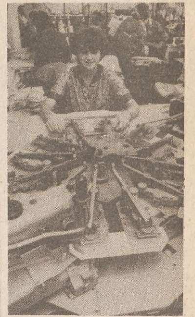
CSRS. Wprowadzenie takich pół-automatycznych maszyn krawieckich, wszywających np. mankiety, kołnierzyki itp. do koszul, piżam i innych wyrobów, znacznie zwiększyło produkcję zakładów odzieżowych w Vimperku.
