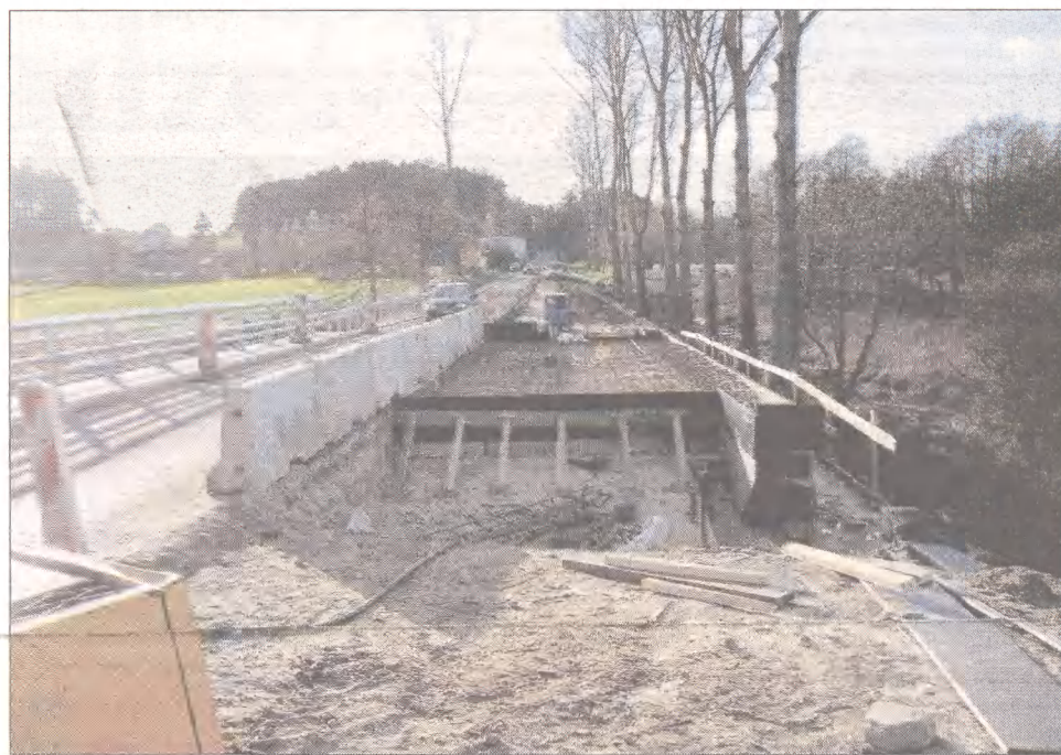
Przebudowa mostu w Niezabyszewie.
