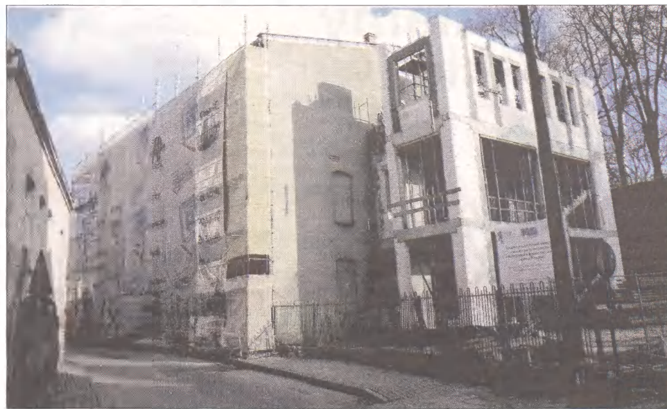
Budowa inkubatora przedsiębiorczości w Bytowie.
