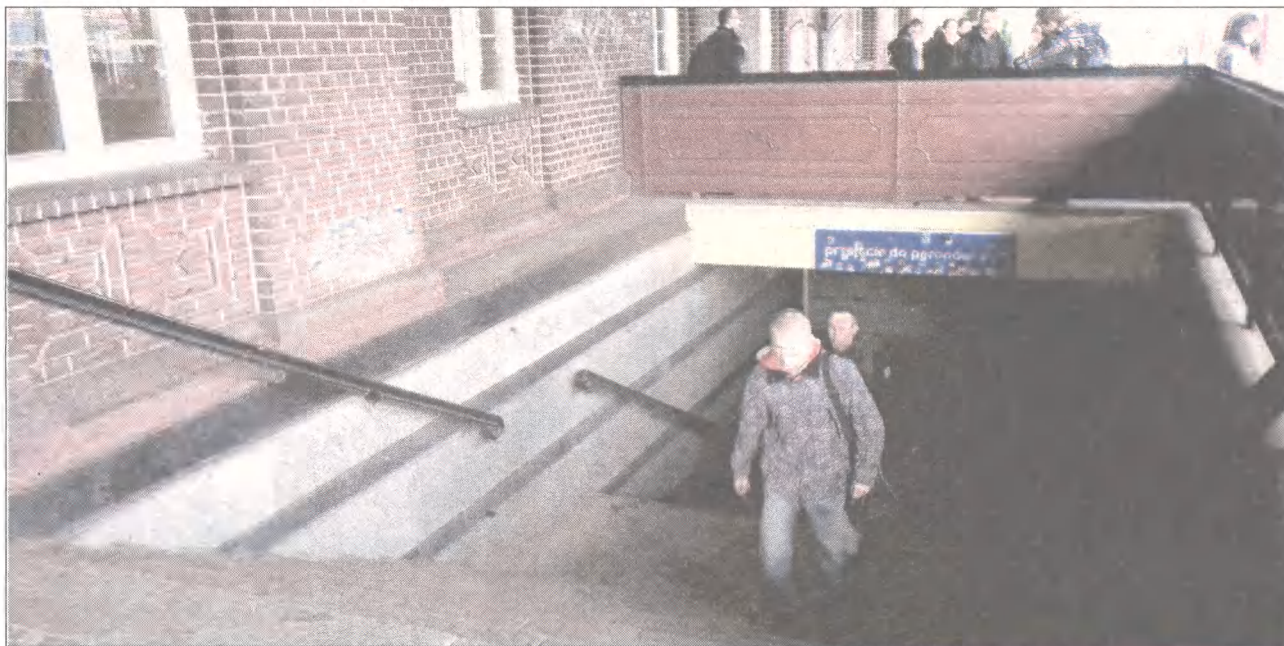
Tunel dworcowy będzie przebudowany. Połączy dworzec z ulicą Żeromskiego, a poprzez nią z ulicami Sportową i Toruńską.
