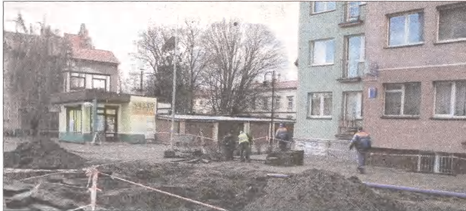
Prace na ulicy Orzeszkowej w Lęborku.
