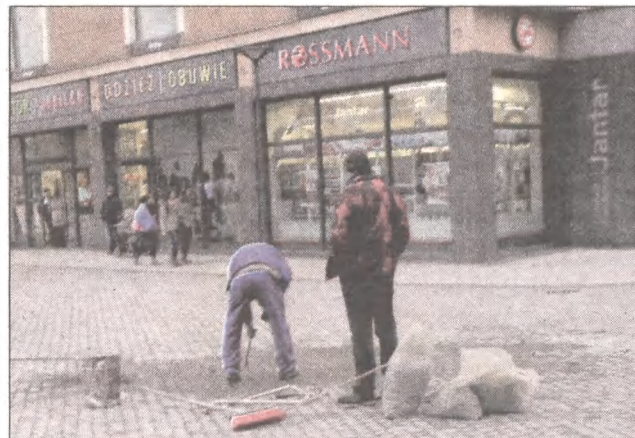
Wyównywanie nawierzchni placu.
