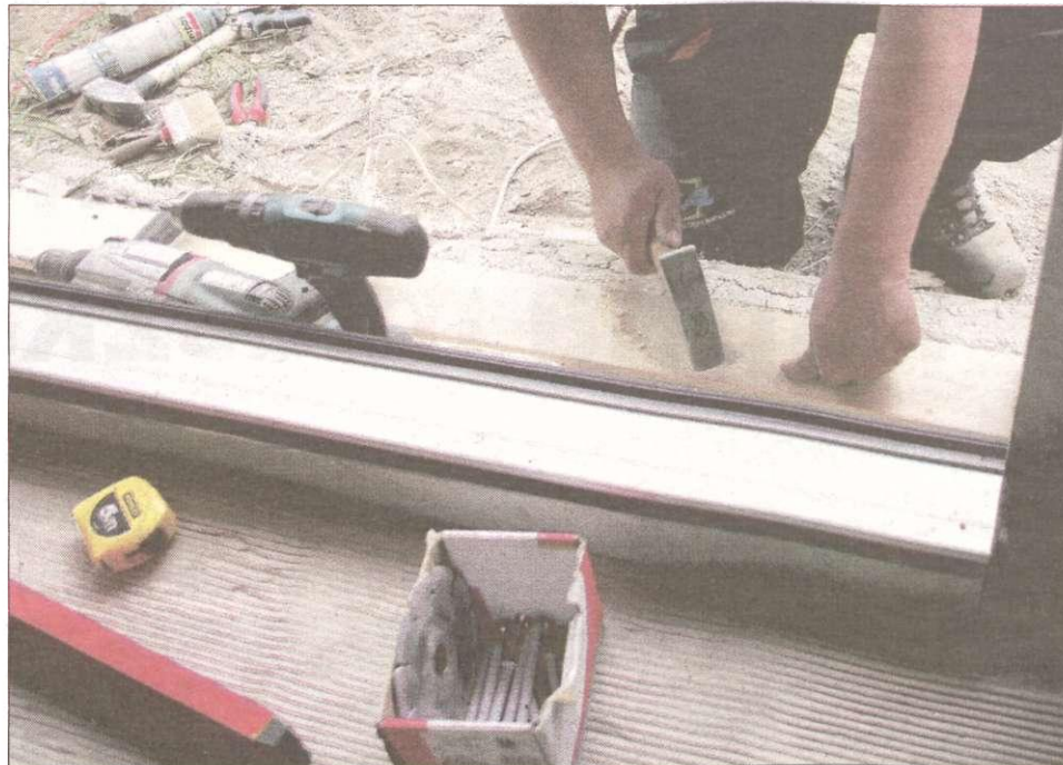
Ciepły montaż progu pozwoli uchronić przed sianem domu przed wychłodzeniem.
