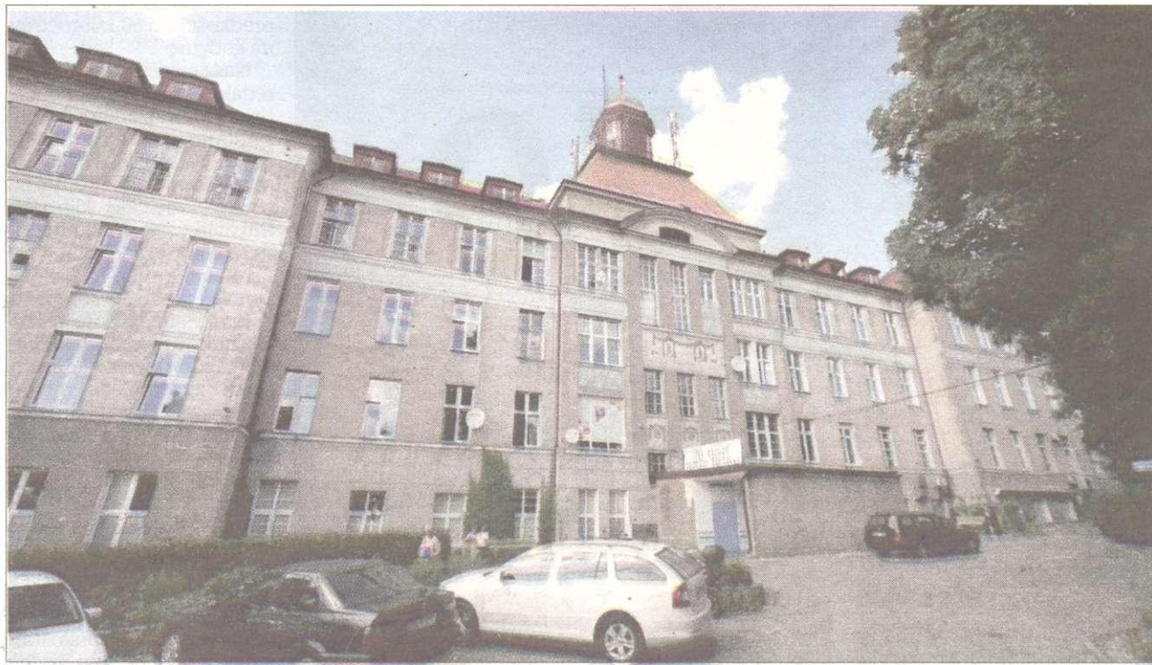
Szpital zostanie wyremontowany, prace podzielono na trzy etapy.
