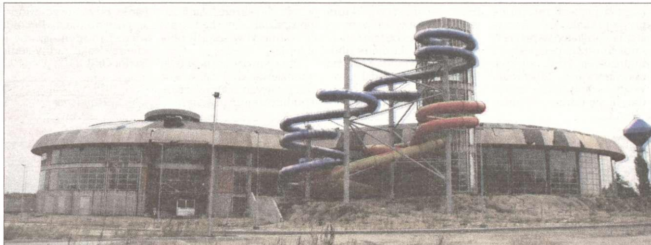
Akwapark niszczy. Radni sprawdzili, że przecieki z dachu zniszczyły ocieplenie.
