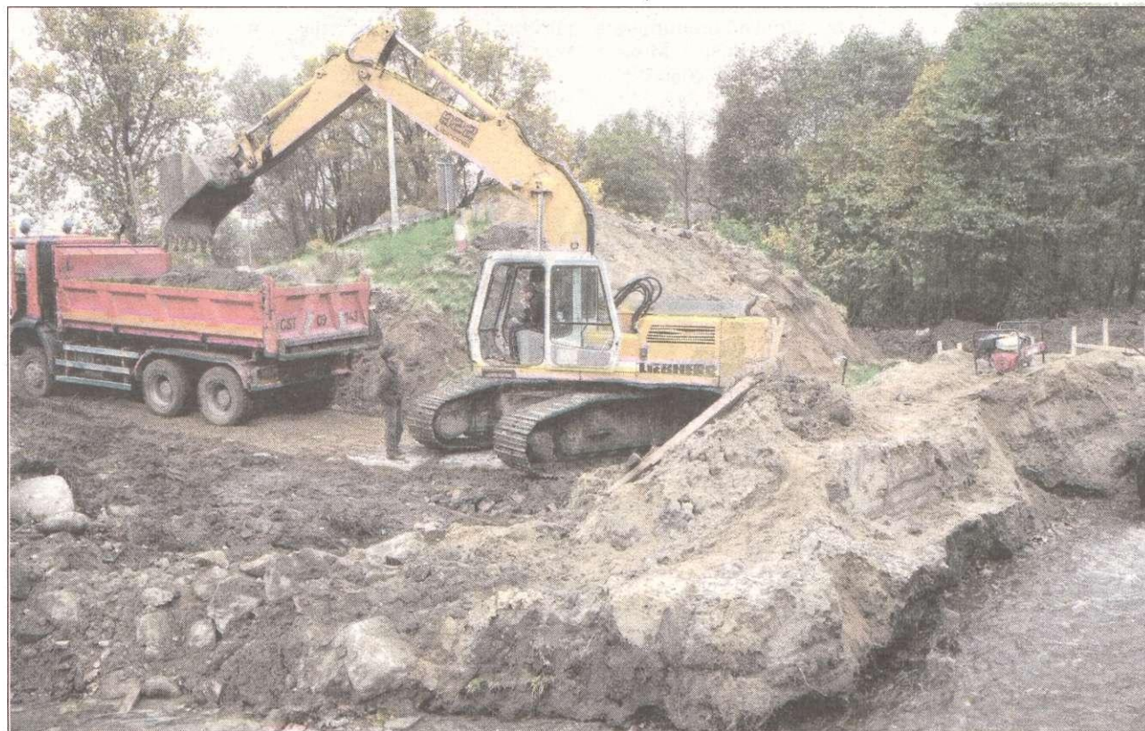
Wznowiono prace przy budowie nowego mostu w Białogardzie.
