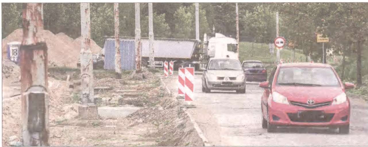
Roboty drogowe na ulicy Piłsudskiego.
