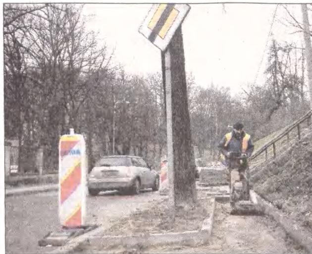
Trwa remont chodnika przy ul. Lotha.
