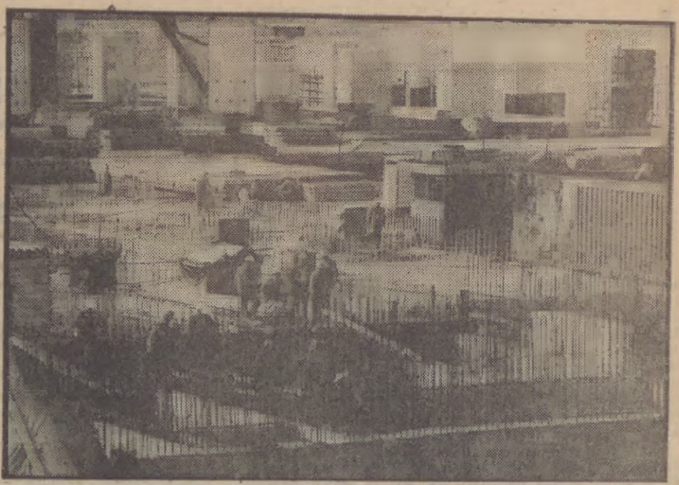
Na terenie budowy Elektrowni Jądrowej w Żarnowcu trwają intensywne prace. Betonuje się warstwę ochronną izolacji tunelu technologicznego i montuje zbrojenia przyszłego zbiornika ścieków aktywnych. Rozpoczęto też budowę budynku gospodarki odpadami promieniotwórczymi. N.z.: prace przy budowie zbiornika ścieków aktywnych.
