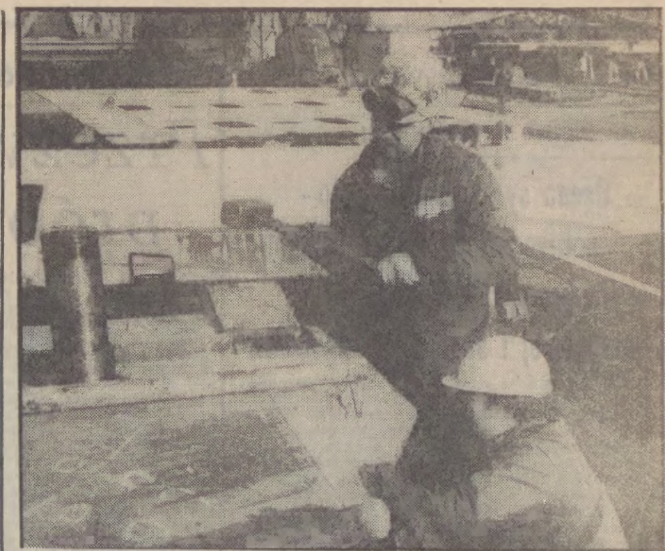
W gdańskiej Stocznii Im. Komuny Paryskiej pracuje. Na poszczególnych wydziałach i w dokach powstają nowe kadłuby statków a przy nabrzeżach, na niektórych z nich trwa ich wyposażanie. Z 11 statków handlowych, którymi dysponowała Polska Żegluga Bałtycka w Kołobrzegu, pozostało do tej pory dziewięć. Wkrótce jednak, ze względu na wiek i zużycie, wycofane zostaną dalsze cztery jednostki. Dojście do tego, że pod koniec 1988 r. PZB dysponować będzie zaledwie 5 trampami. Jest jednak nadzieja, że nie będzie tak źle, ponieważ stocznia Im. Komuny Paryskiej przyjęła zamówienie kołobrzęskiej firmy na budowę pięciu nowych jednostek, a w perspektywie kolejnych pięciu. Pierwszy trawp spłynie na wodę w 1990 r.
