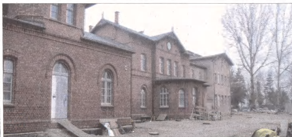
Trwają prace przy kompleksowej przebudowie lęborskiego dworca. Postępy robót widać gołym okiem. Na budynku położono już nową elewację i wstawiono nowe okna. (ZIDA)
