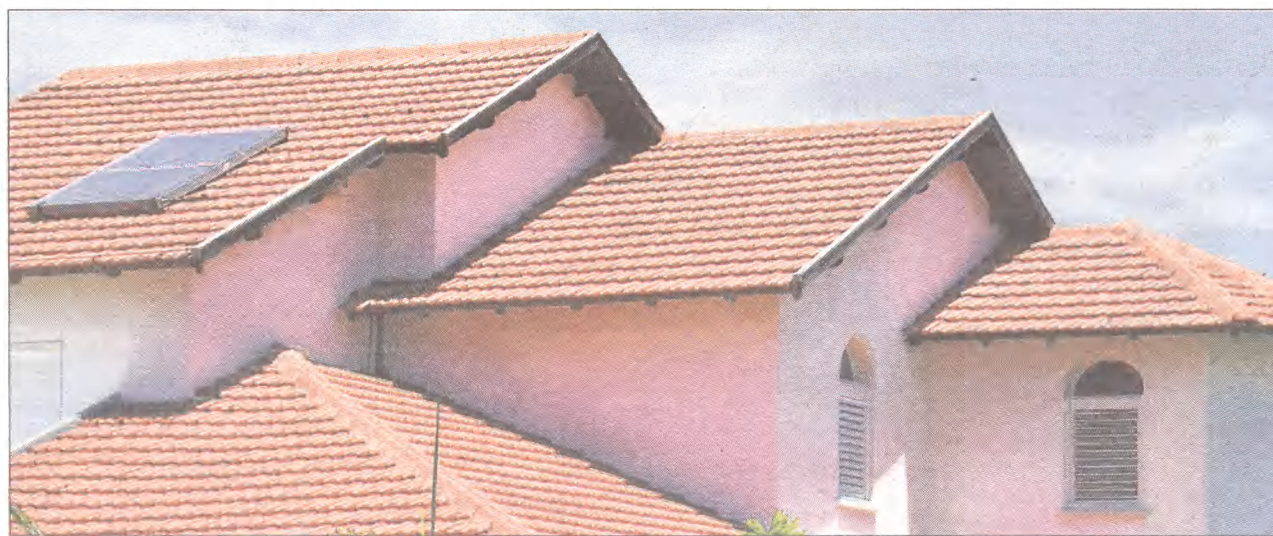
Zadbany dach jest nie tylko ochroną ale także wizytówką każdego domu.
